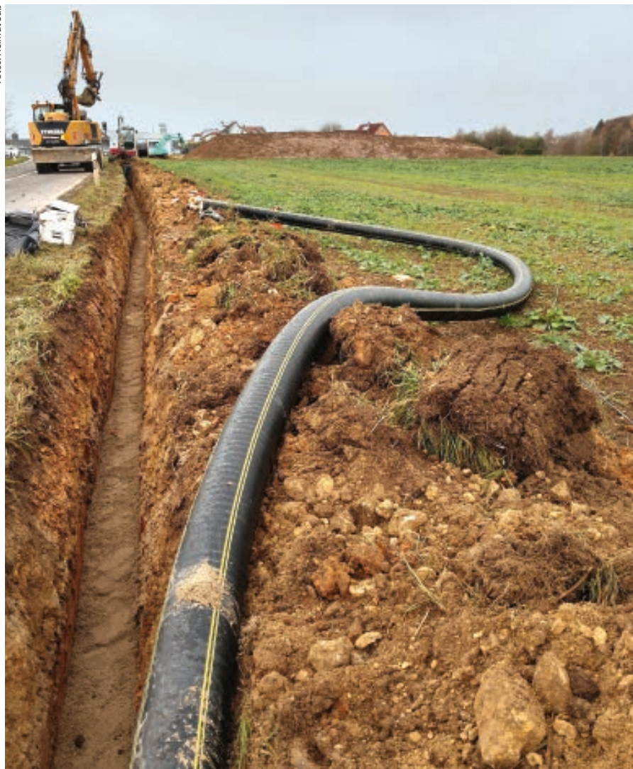
Das Nahwärmenetz in Kastl ist insgesamt 15 km lang mit 180 Gebäudeanschlüssen.
