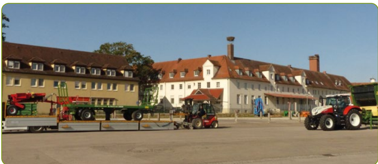
In der Baumaßnahme II entstehen hier die neuen Lehrhallen des FEL.
